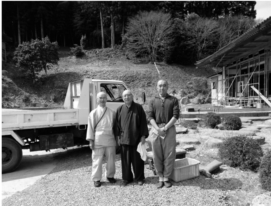
仮本堂復旧工事現場前で津龍院様（南三陸町）と舘寺規弘さん（桑港寺国際布教師）
